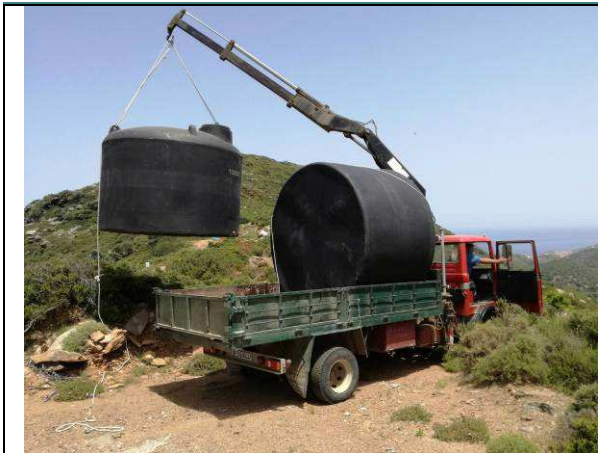
Εγκατάσταση δεξαμενής πυρόσβεσης
