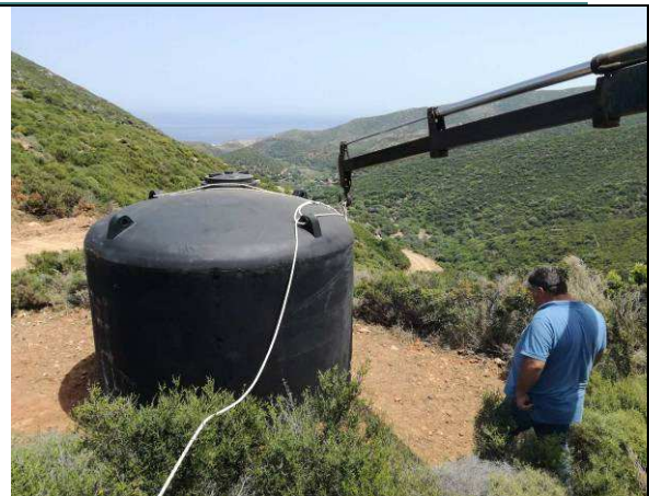
Εγκατάσταση δεξαμενής πυρόσβεσης
