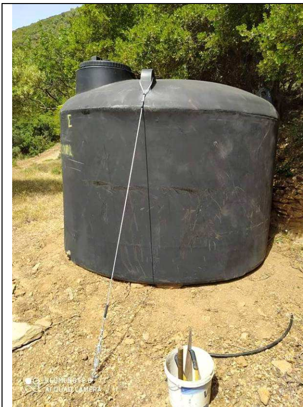
Εγκατάσταση δεξαμενής πυρόσβεσης. Διακρίνεται το συρματόσχοινο πάκτωσης στο έδαφος
