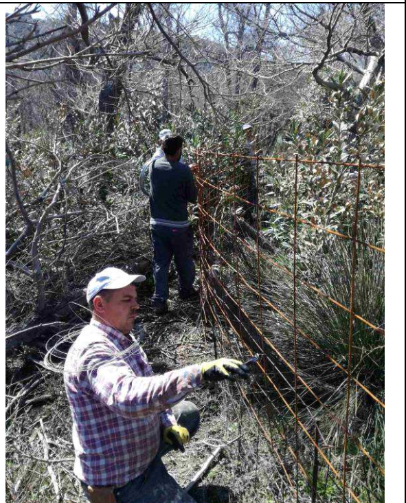
Ενίσχυση πλεγμάτων καθ' ύψος
