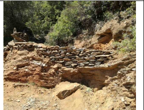
Επισκευή πέτρινου τοίχου αντιστήριξης (Λεύκα)
