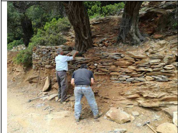
Επισκευή πέτρινου τοίχου αντιστήριξης (Βόρη)
